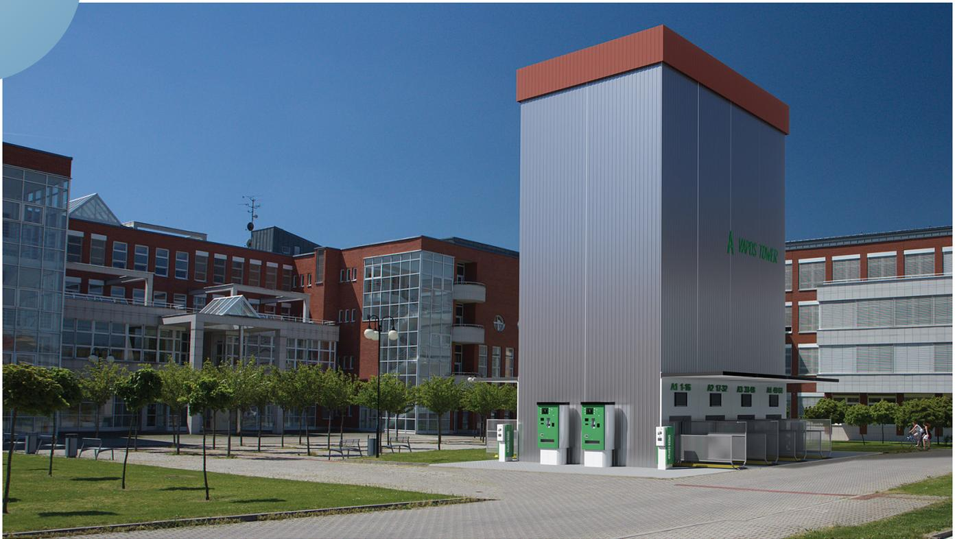
Der Turm besteht aus Modulen aus stahlgeschraubter Konstruktion, in denen sich Aufzüge bewegen. Diese sind zusammen mit den automatischen Eingangstüren über Servoantriebe gesteuert durch das System von der Firma Siemens.
